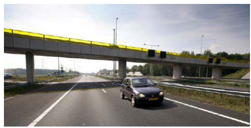
Modulair viaduct (start 2018)
